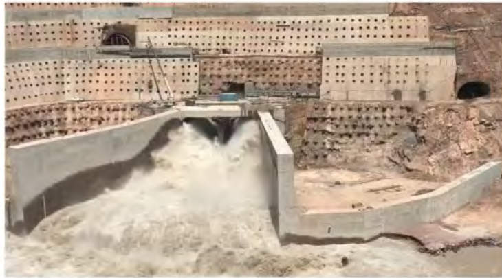
Рис. 5. Сопряжение потока, выходящего из строительного туннеля СТ3, с нижним бьефом в натуре во время паводка
