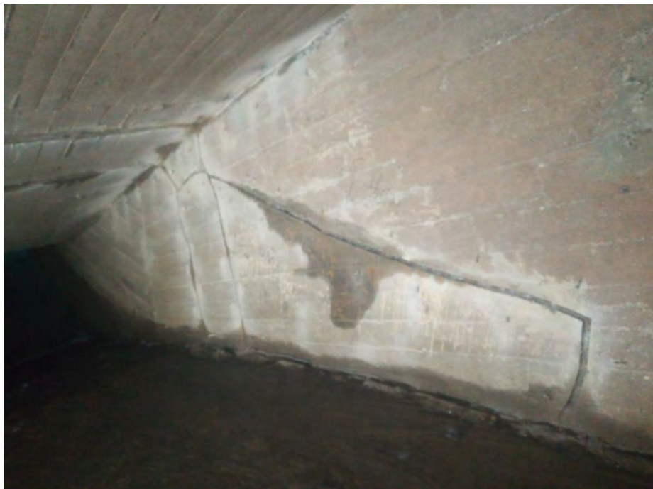
Рис. 4. Фрагмент восстанавливаемого участка холостого водосброса на этапе устройства штрабы
