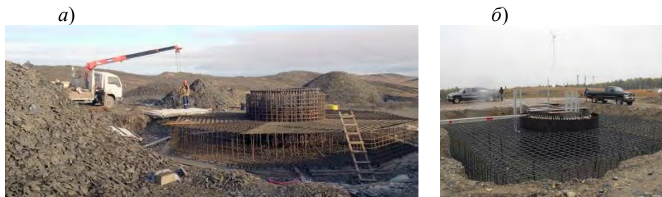
Рис. 1. Процесс возведения монолитных фундаментов ВЭУ в пос. Тикси, Якутия (а) и ветропарка Alaska Environmental Power (США) (б) [2]
