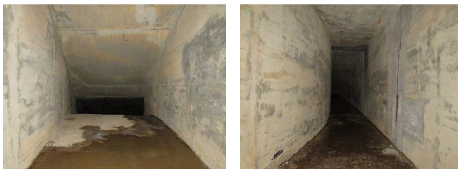
Рис. 1. Общие виды холостых водосбросов Иркутской ГЭС
