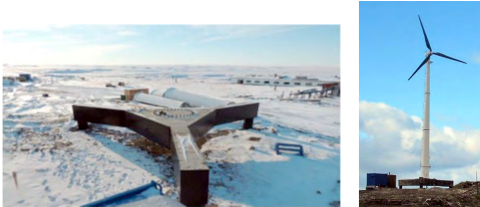
Рис. 5. Фундамент и установленная ВЭУ в пос. Амдерма
