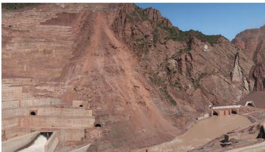
Рис. 4. Выход потока с агрегатов здания ГЭС через строительные туннели СТ1 и СТ2 в натуре
